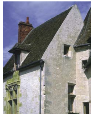
Rue des Chapelains – fenêtres à meneaux.
