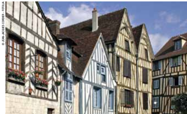
Façades de maisons, quartier de la Marine.
